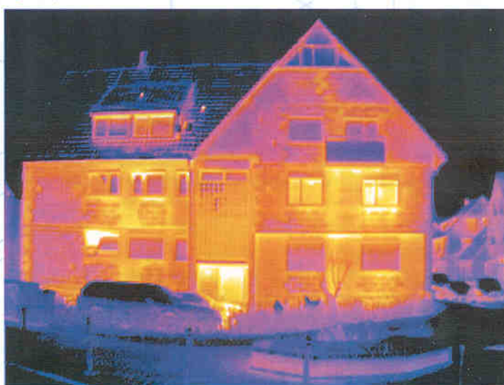
Une caméra thermique infrarouge détecte les défauts d'isolation.
